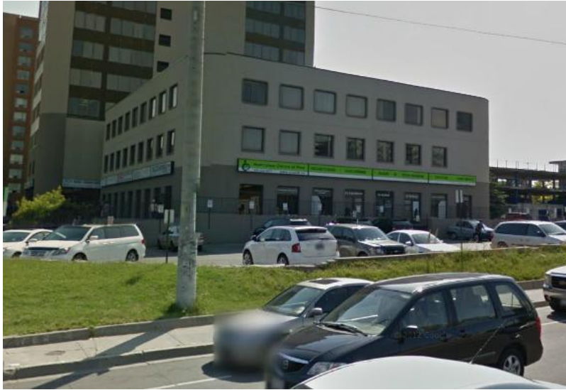
FIGURE 12 : CENTRE D'ACCUEIL DE PEEL, VUE DE L'EXTÉRIEUR
