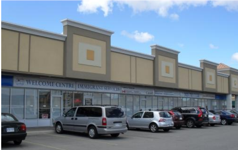
FIGURE 11 : CENTRE D'ACCUEIL DE YORK, EMPLACEMENT DE VAUGHAN, VUE DE L'EXTÉRIEUR
