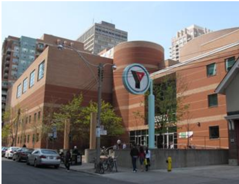
FIGURE 13 : YMCA TORONTO CENTRAL, VUE DE L'EXTÉRIEUR
